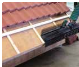
5 Begin aan de rechterzijde met het plaatsen van het eerste Vogelvide element. Breng de RVS torxschroeven & neopreen-volgring aan, door de Vogelvide in de tengels.
