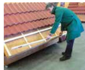
4 ...verwijder dit dan en verwijder de onderste panlat.
