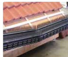
6 Koppel de tweede Vogelvide aan de eerste door de verbinding in elkaar te steken. Monteer vervolgens ook deze Vogelvide met RVS torxschroeven & neopreen-volgring op de tengels.
