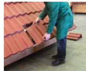
2 Schuif de tweede rij dakpannen omhoog en verwijder de onderste rij dakpannen over de gewenste breedte.
