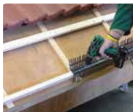
3 Is er vogelwering aanwezig, zoals een Vogelmuisschroot, Vogelschroot, een Kombi dakvoetprofiel of een ander profiel...
