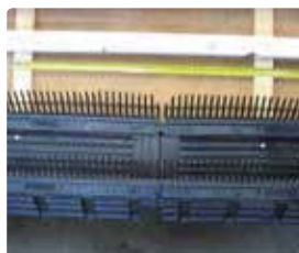
7 Controleer de afstand tussen de tengels ter plaatse van de koppeling van twee Vogelvide elementen. Is de afstand groter dan 500 mm, zorg dan voor extra ondersteuning onder deze koppeling.
