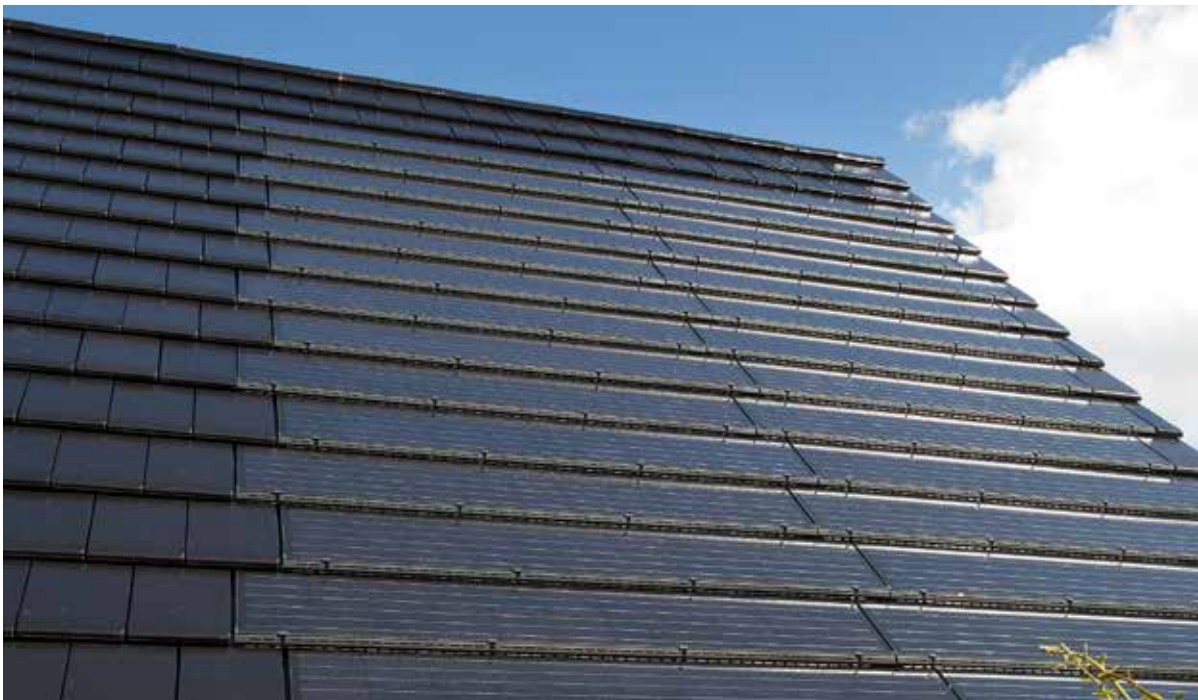
Monier PV Premium systeem - volledig geïntegreerd PV-systeem
