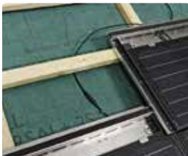
51 Sluit een van de kabels van de eerste module aan op de kabels naar de omvormer. De andere modulekabel wordt later op de module erboven aangesloten.
