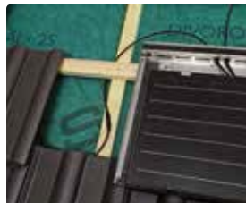
52 Opmerking! Leg de kabels op het niveau van de daktengels – breng ze nooit over de panlatten aan, vanwege het gevaar van bekneling. De connectoren sluiten om veiligheidsredenen stroef op elkaar aan. Zorg voor goede elektrische veiligheid: steek de stekker in de connector tot hij niet meer verder kan!
