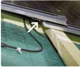
21 De rails van de modules moeten in elkaar grijpen.
