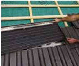
47 Hang de onderste modules op hun plaats. Leg de modules met een zijdelingse overlap van rechts naar links.
