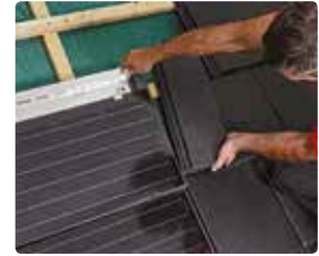
24 Leg op de 2e rij aan de zijkant een halve vlakke dakpan bij. Schroef de module pas daarna vast.
