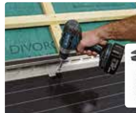
53 Bevestig elke module met telkens 4 schroeven op de panlat, gebruik daarvoor de aanwezige stansgaten. Gebruik de bijgeleverde schroeven van RVS, met afdekplaatje.
