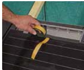
26 Aansluiting bij de nokzijde Plak de bijgeleverde schuimstrook op de bovenste glasrand van de module. De schuimstrook dient als beschermende laag ten opzichte van de erboven gelegen vlakke dakpannen.
