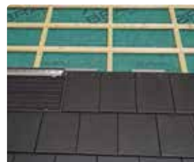
31 Neem een dakpan weg en plaats een korte profielrail. Boor de betreffende dakpannen voor met een dakpanboor en schroef ze vast. Gebruik voor het voorbereiden de sjabloon.
