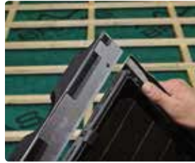
44 Aansluiting aan de dakvoet Bevestig aan de onderkant van iedere module op de onderste rij een dakvoetaansluitprofiel. Fixeer het profiel door het op de module te schuiven.
