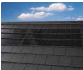
29 Compleet gelegd moduleveld.
