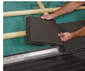
27 Leg vervolgens de dakpannen bij.
