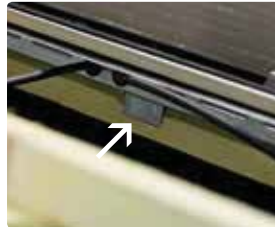
48 Schuif de modules zo ver naar beneden dat de ophangnokken tegen de panlat liggen.
