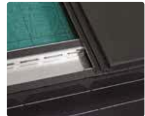
28 Juist geplaatste Stonewold-dakpannen.
