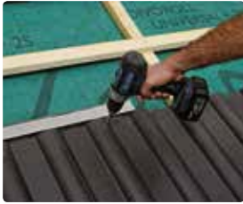
43 Schroef de dakpannen vast.
