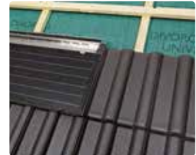
50 De dakpan die aan de rechterkant aansluit kan zowel voor als na het leggen van de module worden gelegd.
